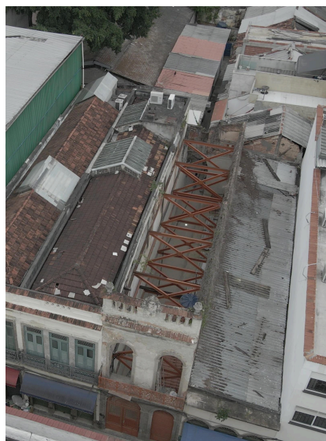
Imagem 2: Vista aérea da vila Av. Modelo Fonte: RioTech Drone, 2022
