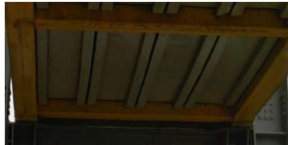
Figura 1. Detalhe da laje pré-moldada apoiada nas vigas transversinas.
