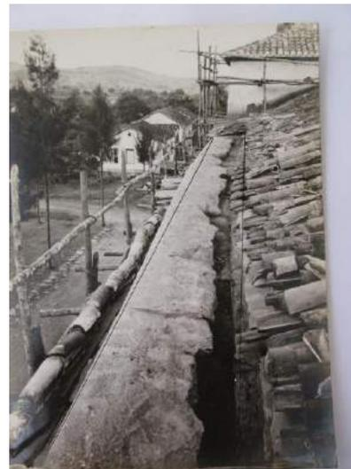
**Figura 1 - Projeto de alinhamento de parede desaprumada da Casa do Padre Toledo. Nota-se que a técnica utilizada (sobreposição de proposta sobre foto) é recomendada na Carta de Atenas de 1933.**
