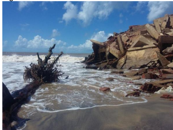
Figura 1: Erosão costeira em Atafona
