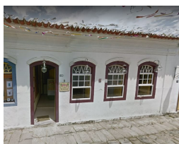
Fig. 6: Rua Tenente Francisco Soares nº100, Paraty - Imagens obtidas no fundo Obras do IPHAN e no Google street view.
