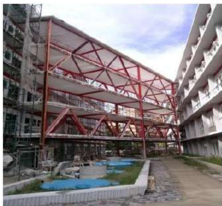
Figura 1: Passarela de Pedestre instrumentada
