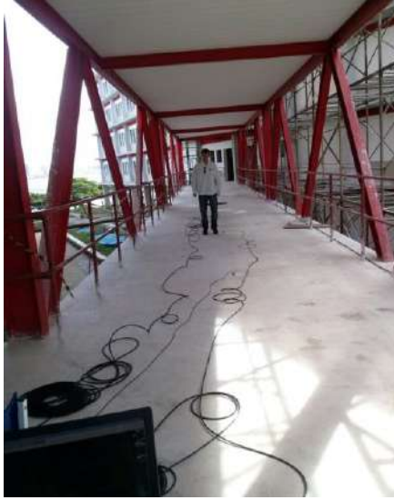
Figura 5: Ensaio da passarela.
