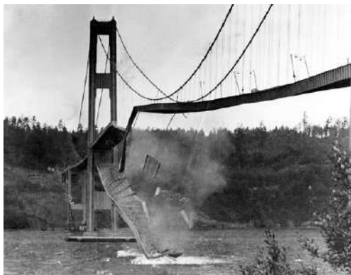
Figura 1: Colapso da ponte de Tacoma (1940).
