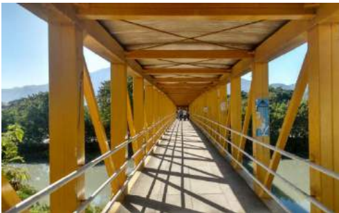
Figura 3: Foto da Seção Transversal da Passarela
