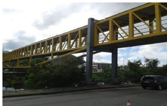
Figura 1 – Foto da passarela
